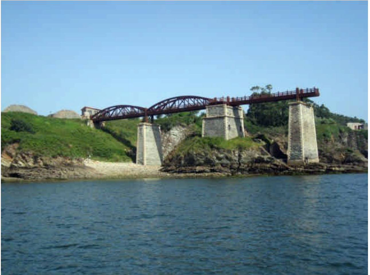
Alte Brücke über die Bucht von Ribadeo.
